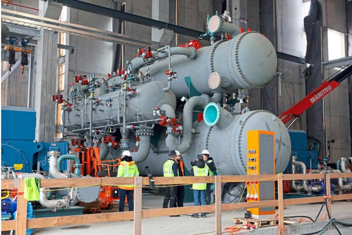
**Großwärmepumpe mit 55 MW (Wärmeleistung)**
